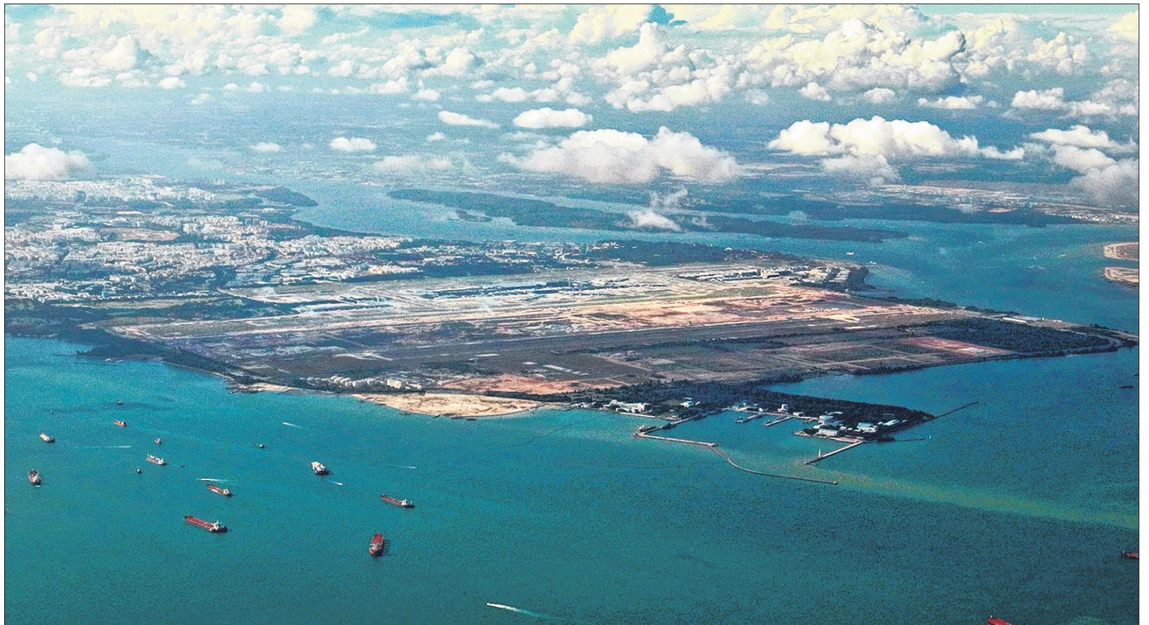
如果冠病疫情持续, 樟宜机场第五搭客大厦、大士港口、新地铁站及新一代公路电子收费系统的落成时间表可能受影响。图为第五搭客大厦施工现场的鸟瞰图。(档案照片)
