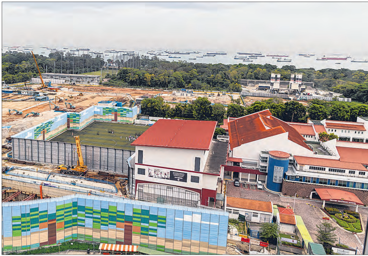
东海岸碧湾区的土地工程和工地清理拟定明年展开，预计2029年完成。这块土地以北是兴建中的汤申—东海岸线地铁站工地，以南是东海岸公园大道。（陈来福摄）
