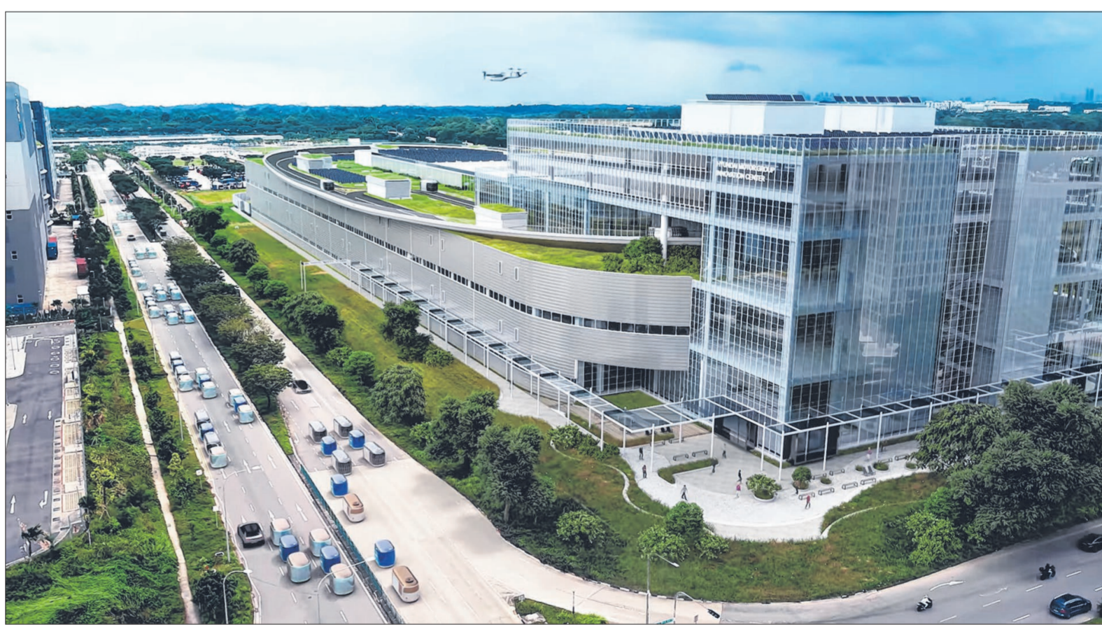
七层楼高的现代汽车集团新加坡创新中心, 楼顶设有620米长的空中车道。未来客户在定制的车子完工后, 就可在空中车道试车。(现代汽车集团YouTube截屏)
